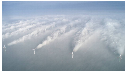
Wirbelschleppen im Nachlauf eines Windparks. Quelle: Vattenfall
